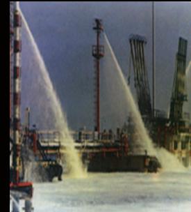
Köpüklü Yangın Söndürme Sistemi
